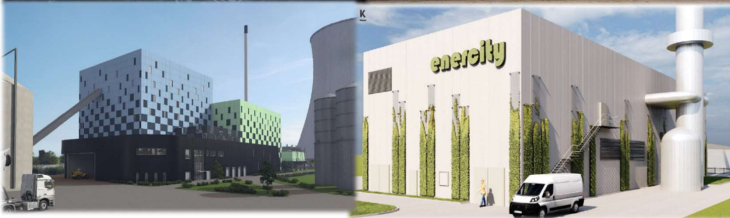
Biomasse- Heizkraftwerk und Großwärmepumpe Stöcken
