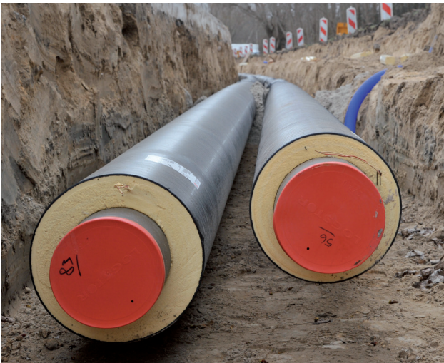
Bau einer Fernwärmeleitung. Quelle: Stadtwerke Rostock AG
