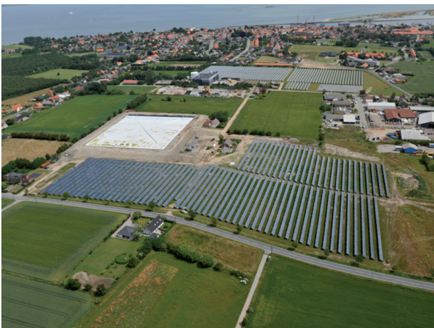
Solarfelder mit Langzeitwärmespeichern Quelle: Marstal Fjernvarme A.m.b.a
