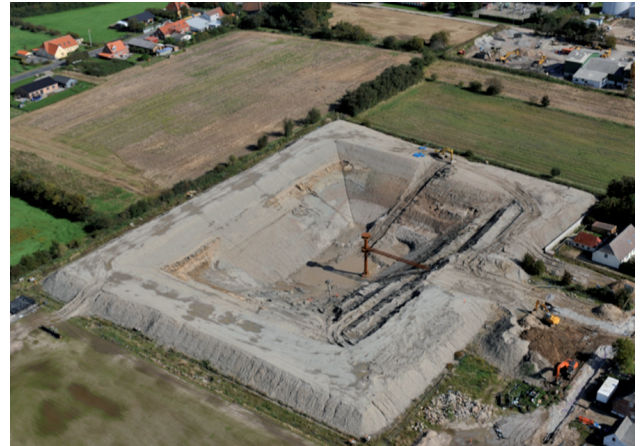
Langzeitwärmespeicher im Bau Quelle: Marstal Fjernvarme A.m.b.a
